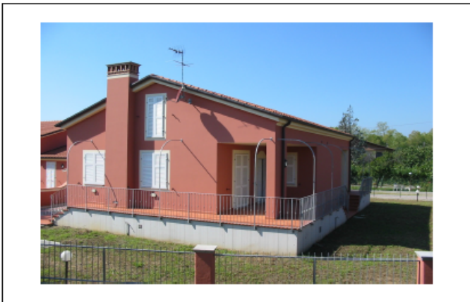
Fotografia B.2 - Edificio XXV Aprile
